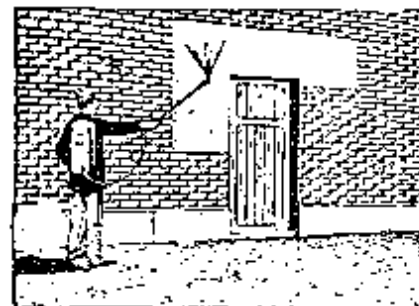
Fig. 377. Het witten der muren met een besproeier.
